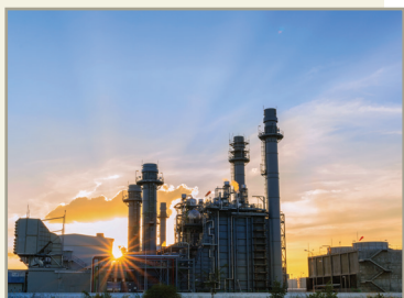
Fig. 15 – Termocentrală cu turbine cu gaze
