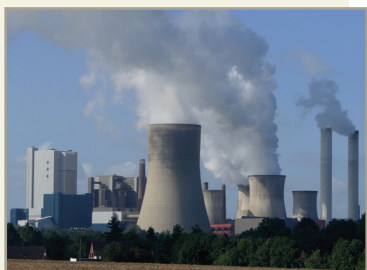
Fig. 14 – Centrală termoelectrică cu cărbuni
