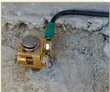
Fig. 28 – Împământarea instalației electrice
