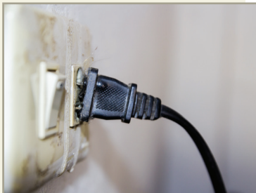
Fig. 40 – Instalatie electrică defectă. Pericol de scurtcircuit și incendiu
