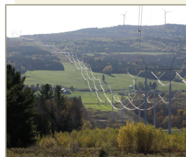
Fig. 45 – Defrișarea zonelor împădurite pentru construirea liniilor electrice
