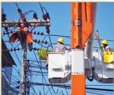
Fig. 37 – Echipament de protecție specific lucrului la înălțime
